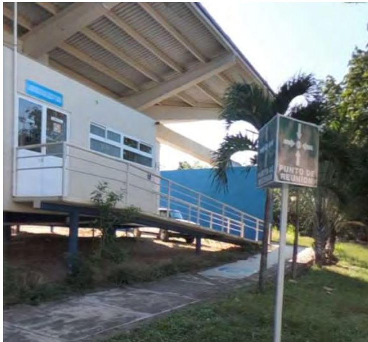
Figura 15. Rampa de acceso a edificio de Agua-Suelo-Planta
