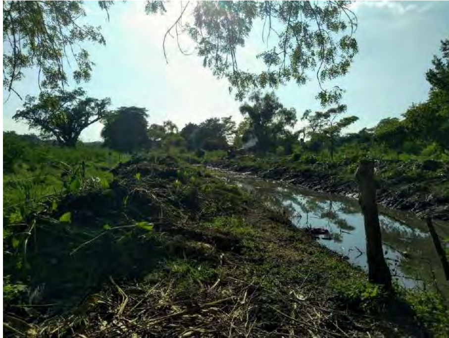
Figura 62. Desazolve de canal de riego
