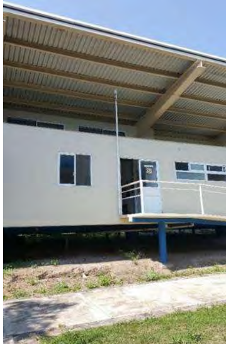
Figura 70. Antena NanoStation M2 externa en Laboratorio de agua-Suelo-Planta (soporta 200 usuarios)
