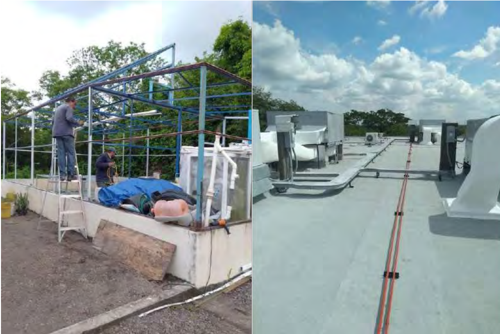
Figura 61. Mantenimiento de casa sombra y de clima integral e impermeabilizante de Edificio de Gobierno
