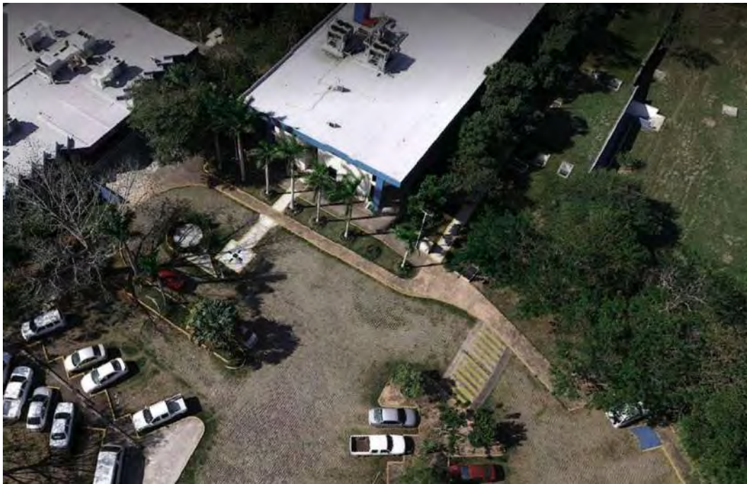
Figura 12. Lugar para personas con capacidades diferentes en estacionamiento, rampas de acceso a edificios
