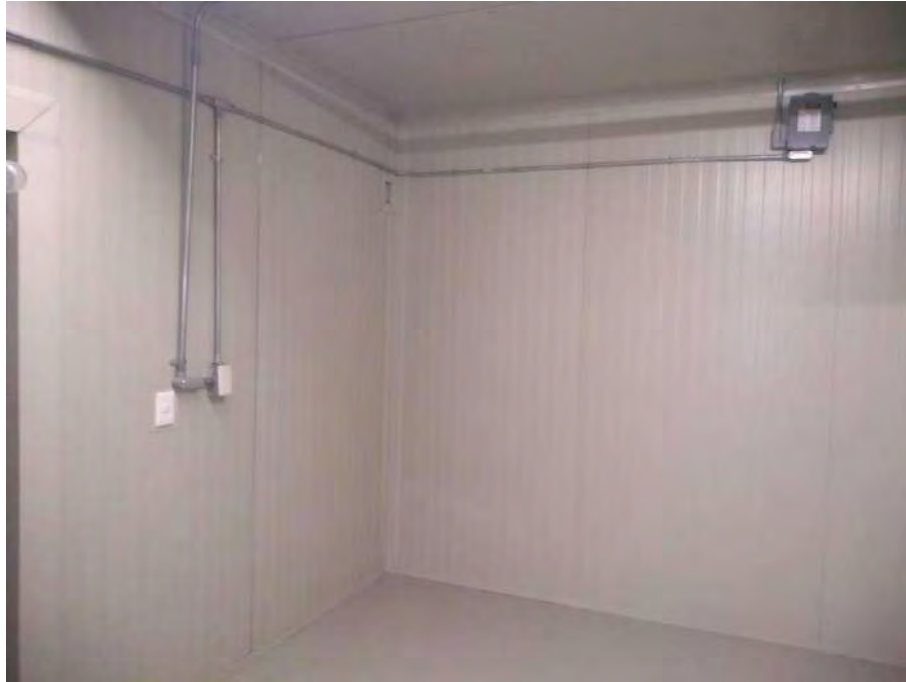
Figura 41. Cámara fría de Planta Piloto de Procesos Agroindustriales (PPPS)
