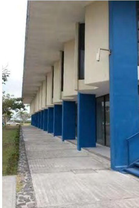
Figura 68. Antena NanoStation M2 externa en edificio cubículos (soporta 200 usuarios)
