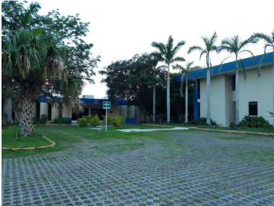
Figura 26. Vista frontal de Edificio de Gobierno y lateral de edificio de Cubículos
