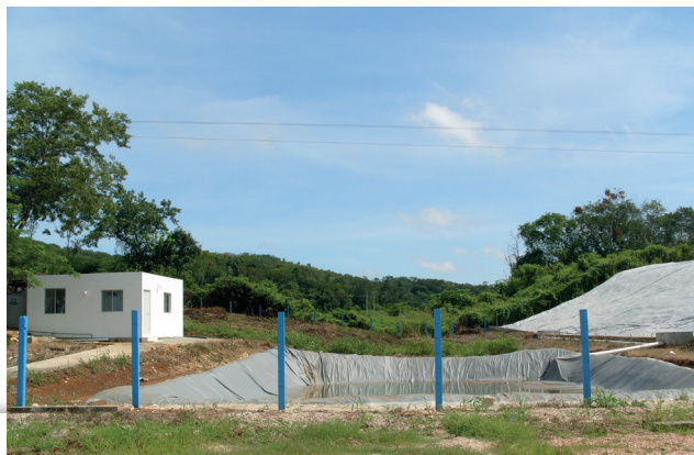
Sistema de Captación de agua de lluvia en el Municipio de Campeche.
