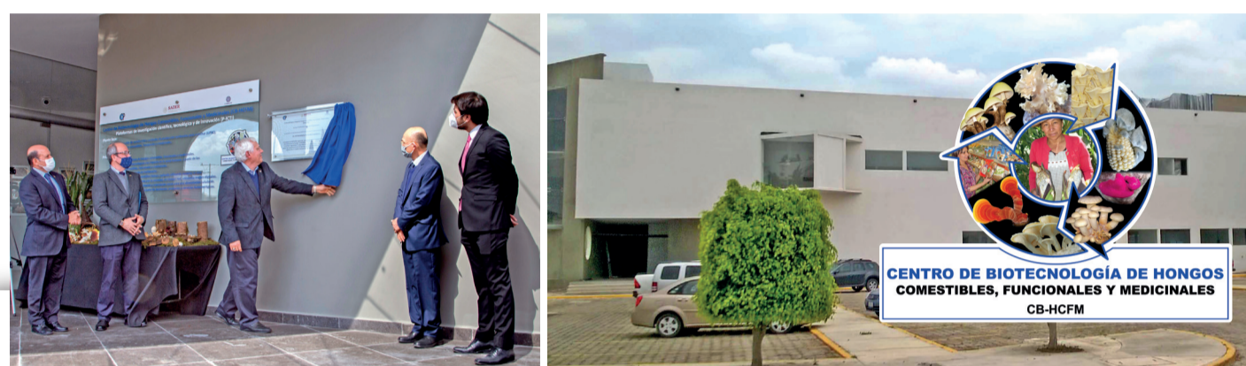
Fig. 1. Centro de Biotecnología de Hongos Comestibles, Funcionales y Medicinales (CB-HCFM) del Campus Puebla del COLPOS.
